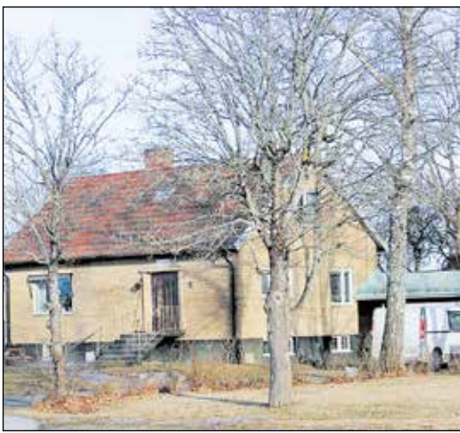
Ett hus, två verksamheter.
